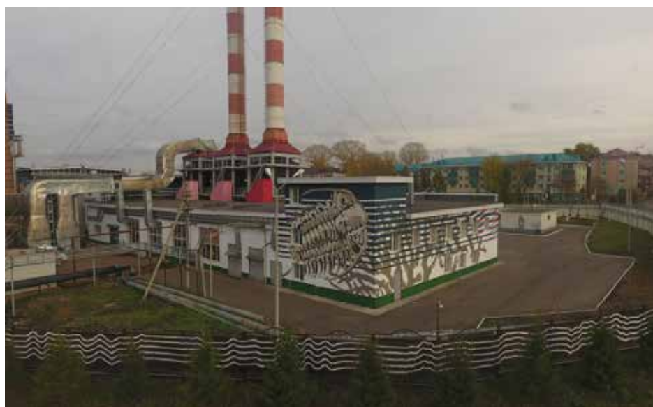
Илл. 8, 9. Резервуары и здания котельной АПТС. «Теории происхождения нефти». Автор Артем Стефанов (Москва), 2018
