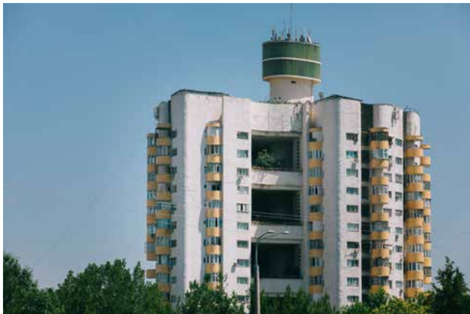
Илл. 2. Экспериментальный 16-этажный дом (1985 год), где советские архитекторы стремились реализовать концепцию «галерейного дома» и «двориков в многоэтажном доме». Дом носит неофициальное название «Жемчуг». Фотография КБ Стрелка / Марк Серый
