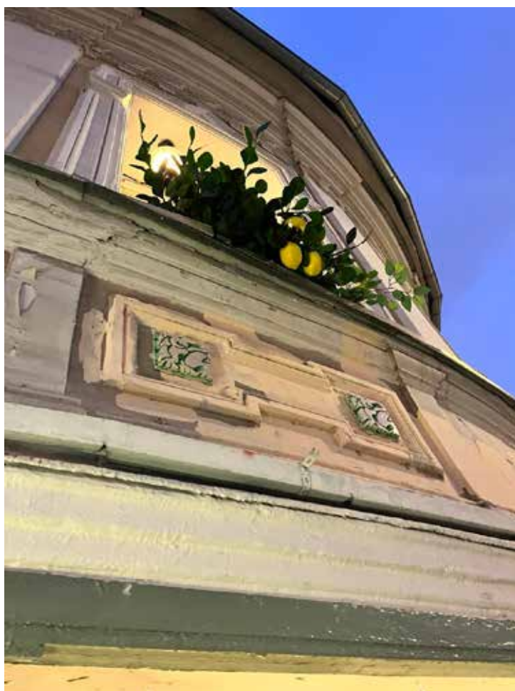
Рис. 7. Два барельефа с анималистическим орнаментом встроены в ансамбль здания и имитируют исторический элемент декора. Ул. Солянка 2/6. Ноябрь 2024
